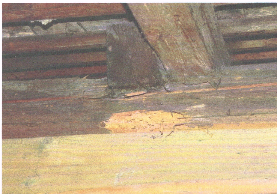
Fot. nr 2 Wypróchnienie ugiętej płatwi w lukarnie północno-zachodniej.
