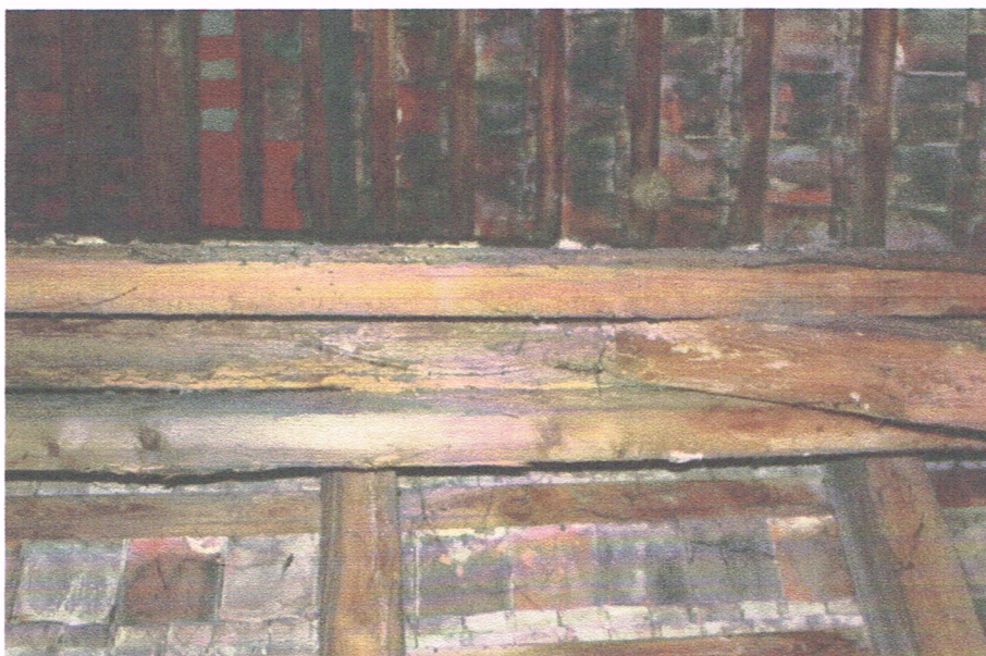
Fot.8 Uszkodzenia płatwi pod murem pruskim w północno-zachodnim szczycie.
