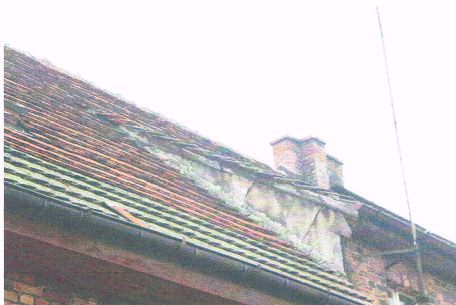
Fot. 18. Przykład zniszczonych obróbek w pseudoryzalitach wejść od strony podwórza.
