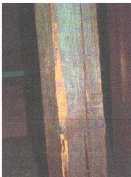
Fot. 3,4 Uszkodzony słup podpierający płatwę w lukarnie północno-zachodniej .
