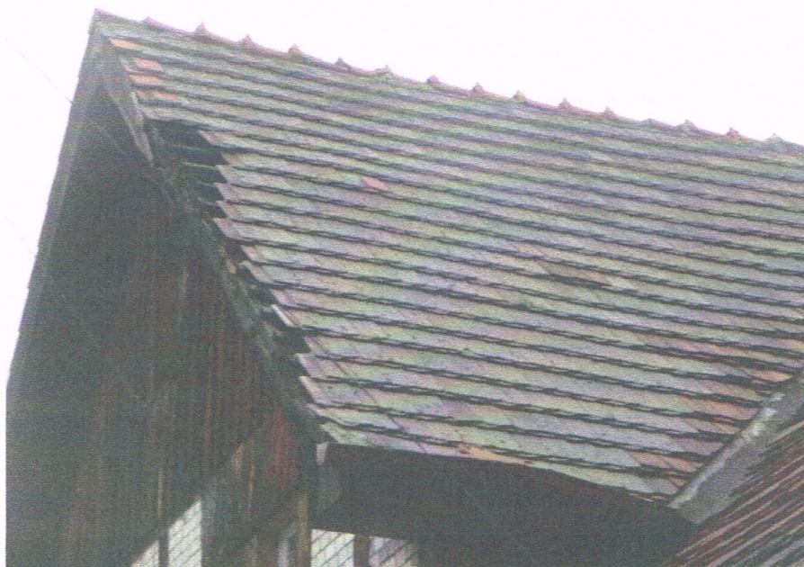
Fot. 14 Facjata w elewacji frontowej - od strony zachodniej, ubytki dachówek na krawędziach dachu.
