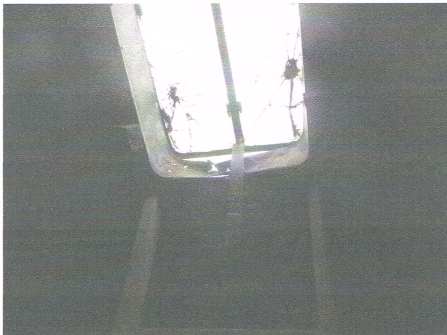
Fot. 19. Uszkodzony wyłaz dachowy
