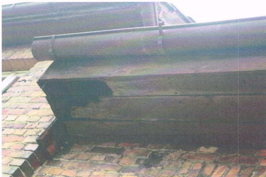
Fot.13 Widoczne uszkodzenia, ubytki drewnianego okapu dachu - deskowanie do wymiany.
