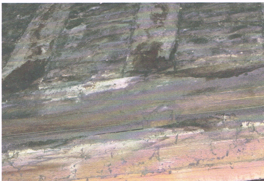
Fot.7 Zniszczona długotrwałym działaniem wilgoci konstrukcja pionowych słupów i podwaliny.
