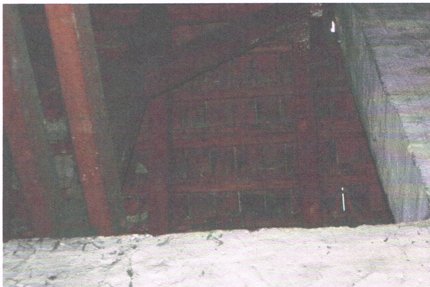
Fot.15 Prześwity w pokryciu dachowym.
