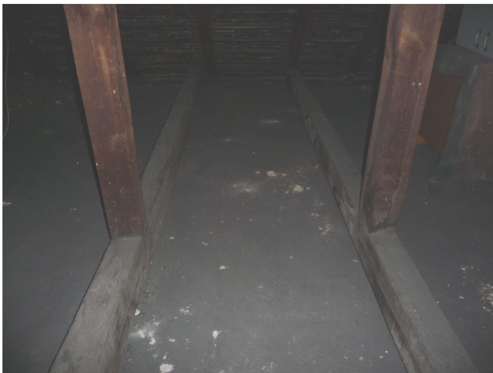
Fot. 10 - więźba dachowa - słupy oparte na podwalinach
