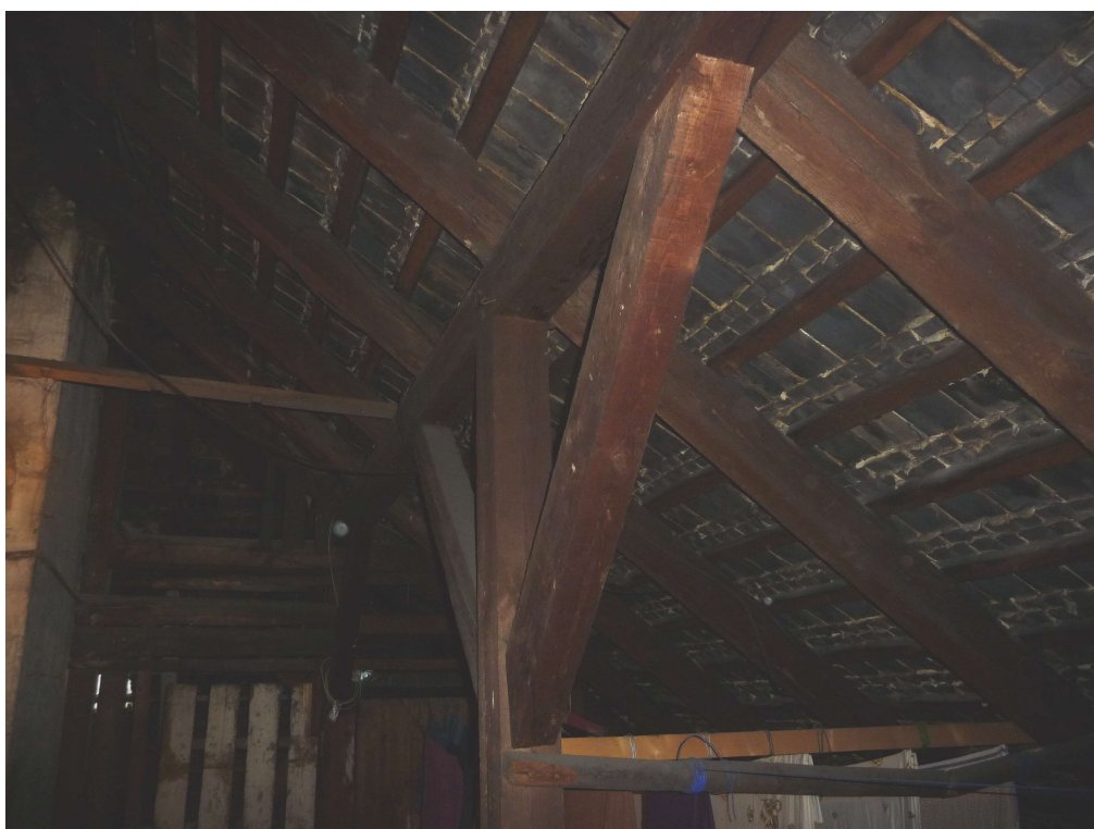
Fot. 12 - więźba dachowa
