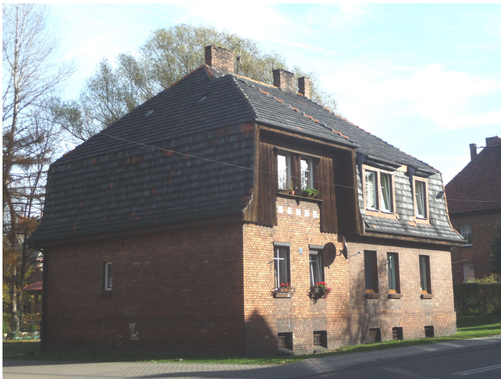
Fot. 1 - elewacja frontowa i boczna północno-zachodnia – widok elewacji od strony ul. Wolności - brak "powieki" na połaci dachu, widoczny "pseudoryzalit" z deskowaniem w górnej części
