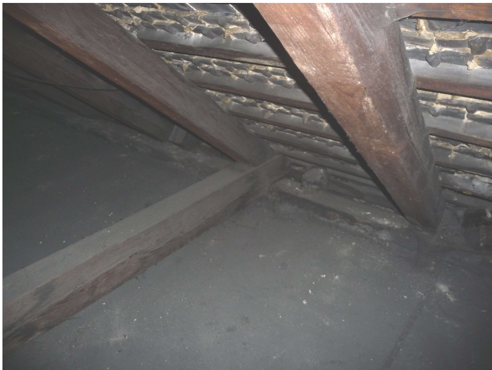
Fot. 9 - więźba dachowa - podwalina ułożona powyżej stropu poddasza
