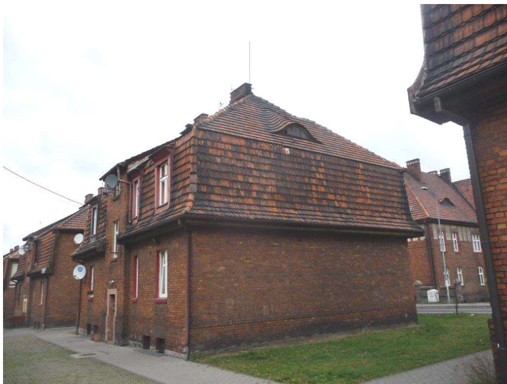
Fot. 5 - bliźniaczy" budynek przy ul. Wolności 16 - widok od strony podwórza, dach z zachowaną "powieką"
